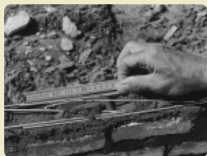
LA SOVRAPPOSIZIONE TRA DUE TRALICCI CONTIGUI DEVE ESSERE DI ALMENO 15 CM
